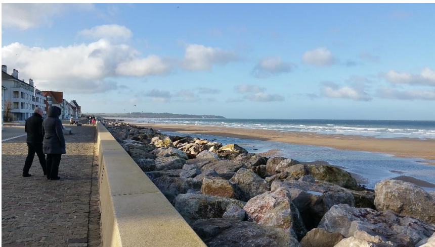
Wissant 2020 : une muraille de blocs, une plage humide et peu accessible
